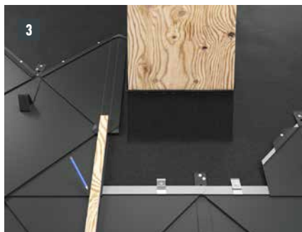
Afbeelding 106 · Schoorsteenomlijsting – daklosange 29 × 29 en 44 × 44 – zijstuk
