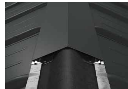
Afbeelding 73 • Nokvorming met enkelvoudige nokkap
