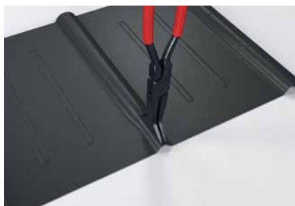
Afbeelding 72 • Eenvoudige nokvorming met inhaalvouw - bijzonderheid bij dakpannen
